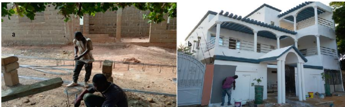
Photo 4 : a) Attacheurs de fer en activité sans mesure de protection ; b) Peintre en activité sans mesure de protection
