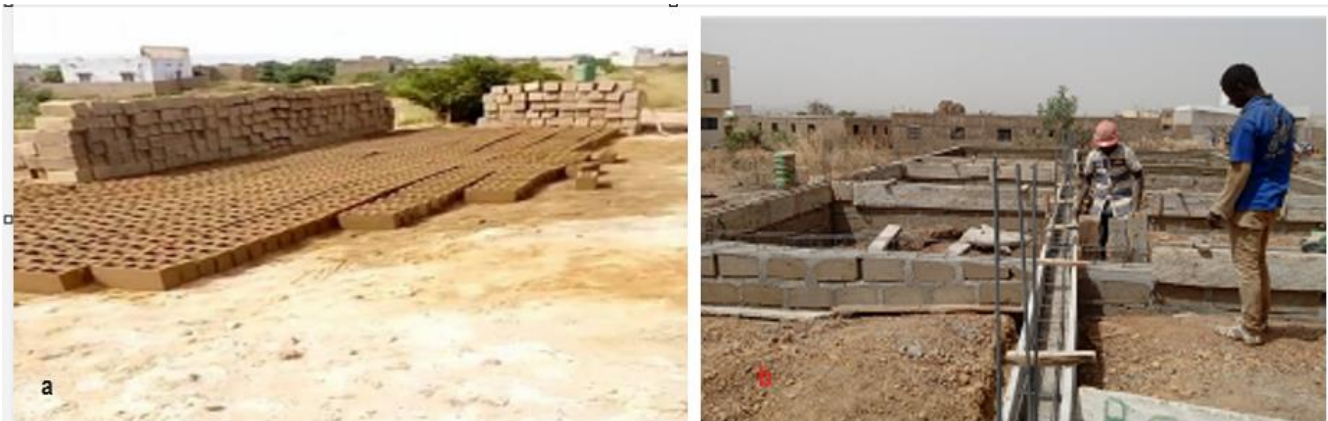
Photo 1 : a) Confection de brique sur un espace aménagé; b) un chef de chantier assistant son maçon à la phase de fondation après aménagement de l'espace
