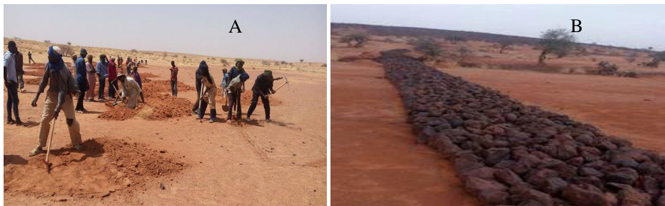
Photo 3 : Réalisation des demi-lunes (image A) et Image d'un cordon pierreux (image B) dans le village de Tacharane (M A, 2020).
